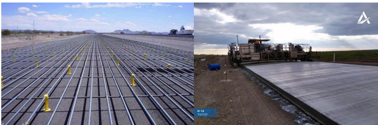
Рисунок 2 – Використання безперервно армованого бетону при будівництві доріг
