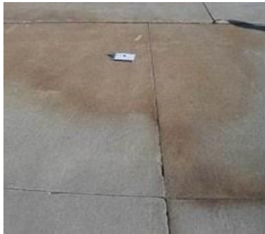
д – витіснення води з-під шару дорожнього покриття;
