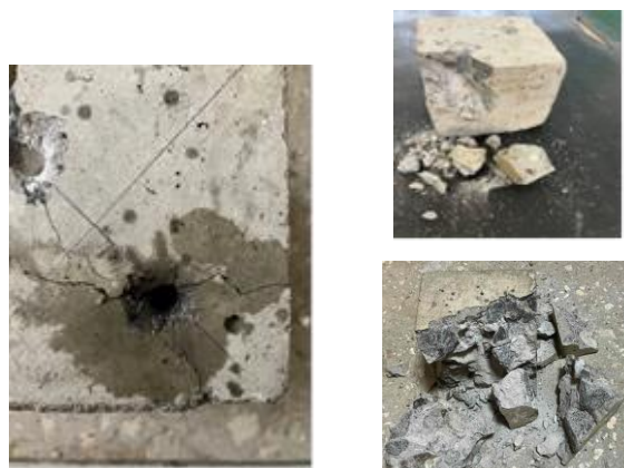
Рис. 3 Характер руйнування бетонних зразків
