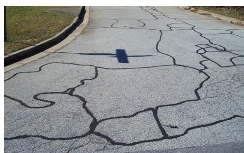
з – тріщини міцності та довговічності у жорстких дорожніх покриттях
