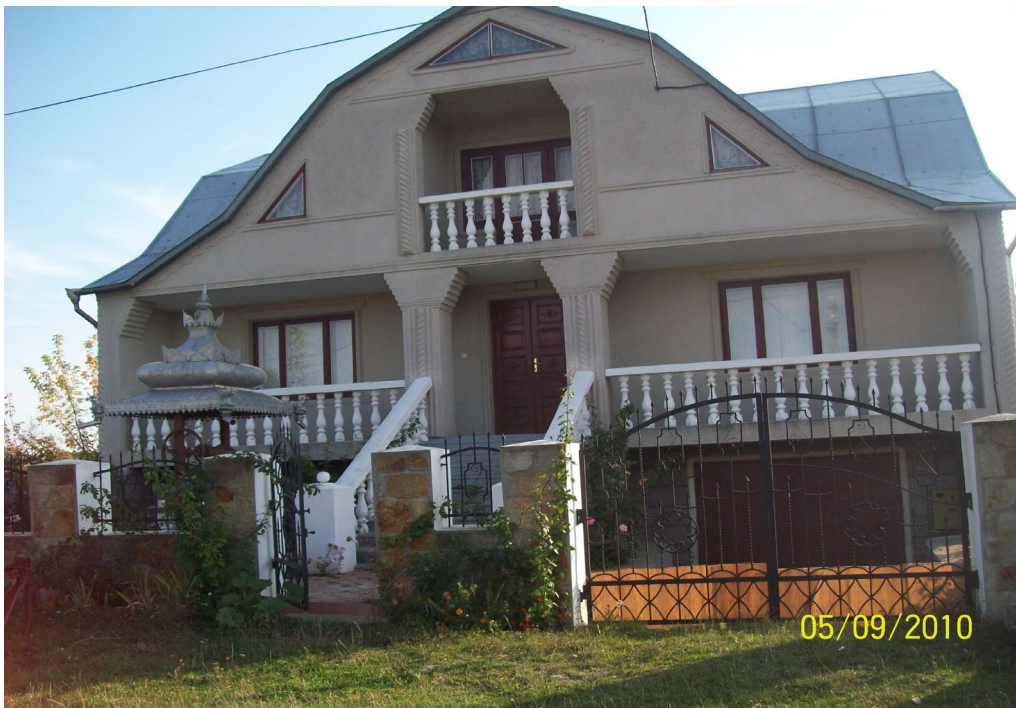
Рис.7 Сучасна житлова будівля в селі Серебря.
