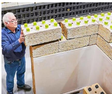
Рис.1 – Вигляд фрагменту стіни з конопляних блоків
