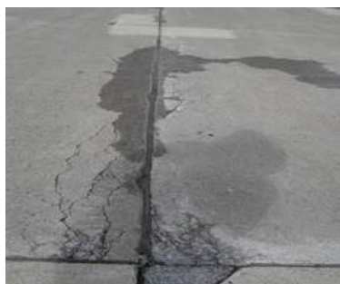
з – тріщини міцності та довговічності у жорстких дорожніх покриттях
