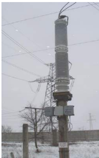
Рис. 1. Конденсатор зв'язку СМА-166/ \sqrt{3} -14 УХЛ1
