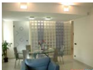
Рис. 4. Приклади перегородок зі скла: а-суцільноскляна перегородка; б-каркасна перегородка; в-перегородка із склоблоків.
