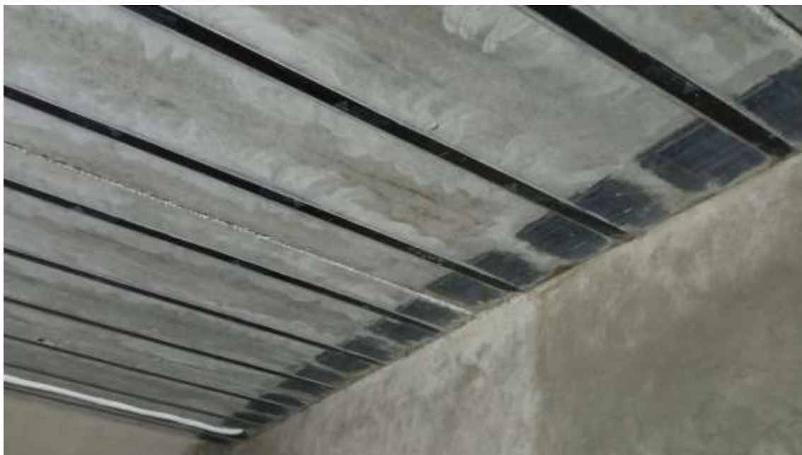
Рис. 2. – Улаштування системи зовнішнього композитного армування виробництва фірми Sika на залізобетонних перекриттях з багатопорожнистих збірних плит.
