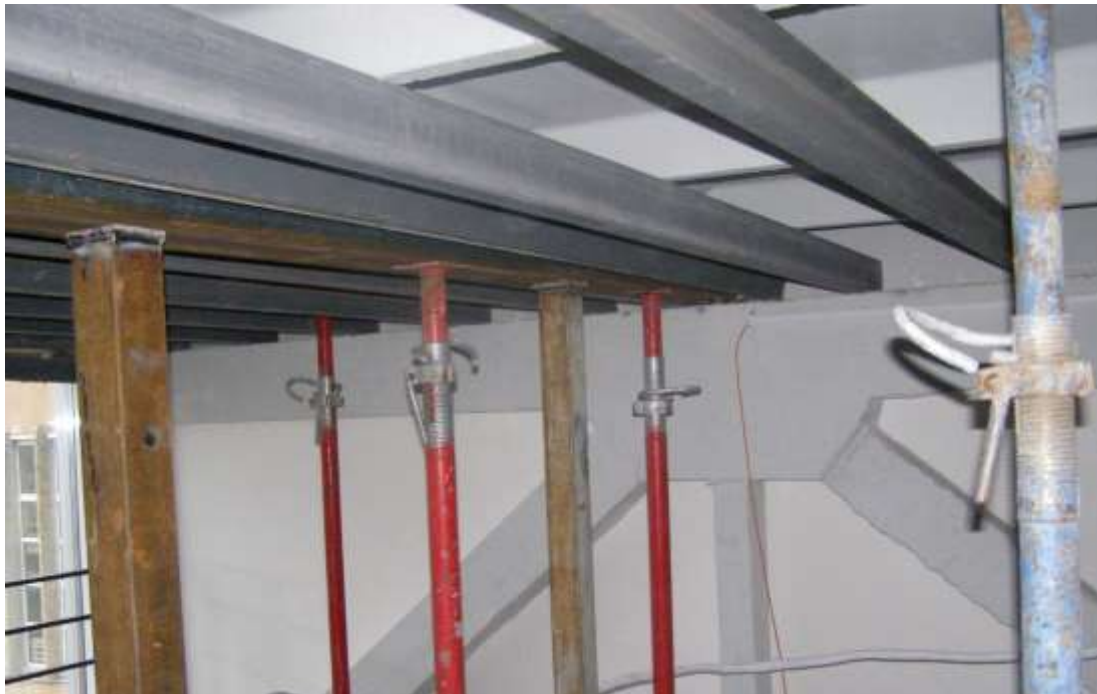
Рис. 1 – Улаштування повздовжніх компактних сталевих балок підсилення (зовнішнього армування) під поперечними ребрами аварійних плит покриття [7].
