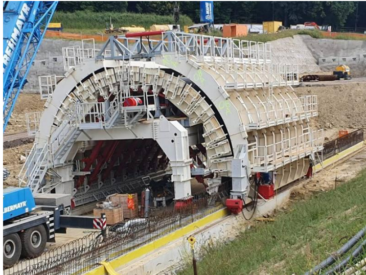
Рис.1 Тунельна опалубка. [5]
