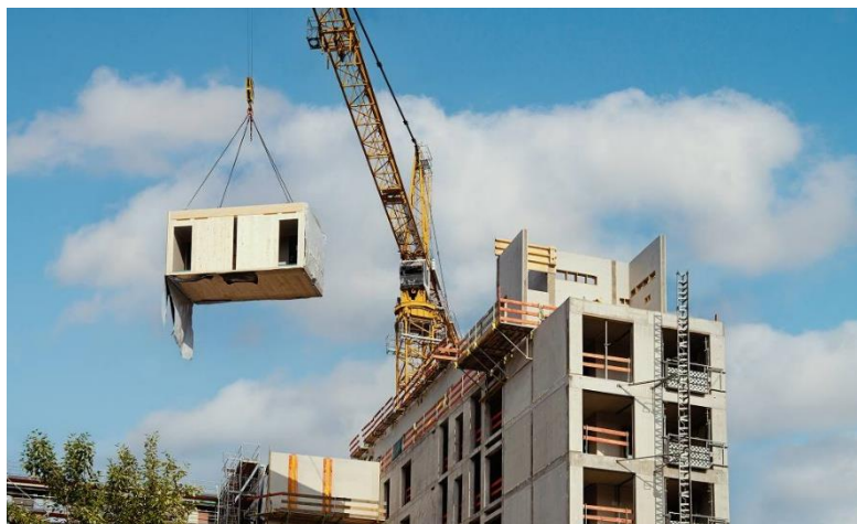
Рис. 1 Монтаж модульних блоків багатоповерхової будівлі [6]
