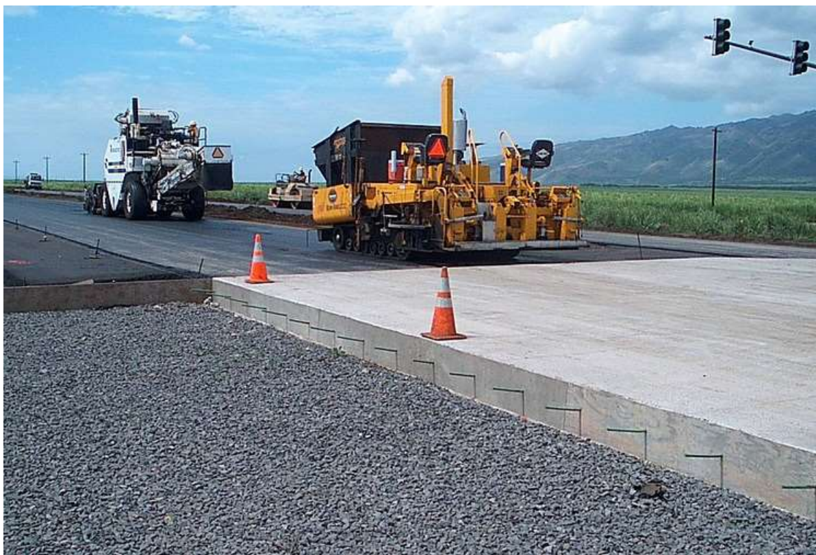
Рис. 1. Будівництво цементобетонної дороги за допомогою спеціалізованої техніки
