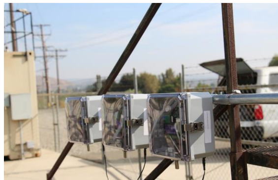
Рис. 4. Розташування сенсорів станції моніторингу атмосферного повітря біля проїзної частини дороги
