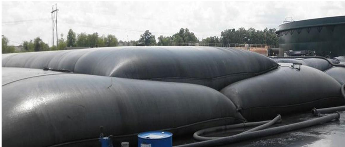
Рис. 5. Зневоднення та зберігання річкового мулу у геотубах.
