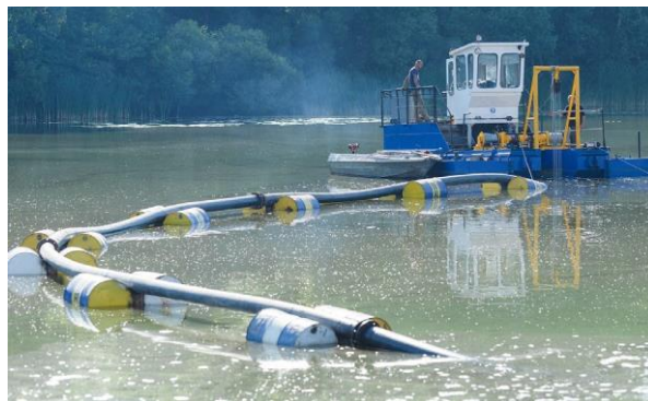
Рис. 2. Робота земснаряда в акваторії Сабарівського водосховища
