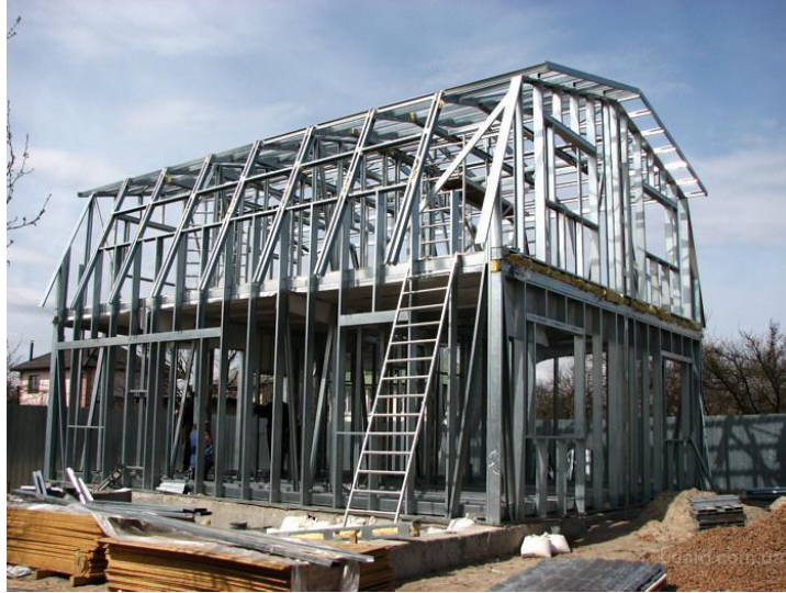
Рисунок 1 – Приклад будівництва модульного котеджу
