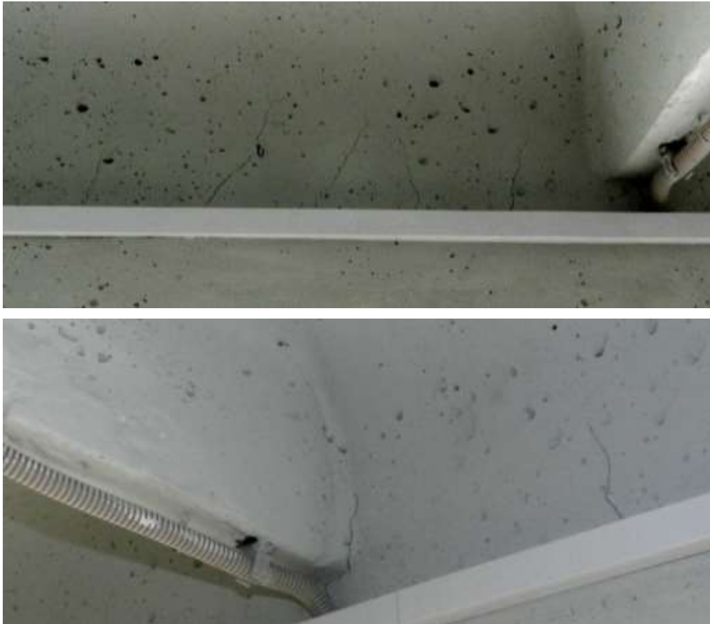
Рис. 4. Масові вертикальні та похилі тріщини на повздовжніх ребрах в зонах між поперечними ребрами та в зоні примикання поперечних ребер.
