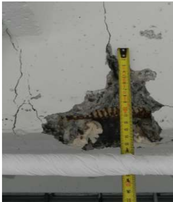
Рис. 2. Дефект повздовжніх плит покриття з різних ракурсів: руйнування бетонного каменю повздовжнього ребра з оголенням, корозією та вигинами повздовжньої арматури, численні силові вертикальні тріщини на повздовжньому ребрі.
