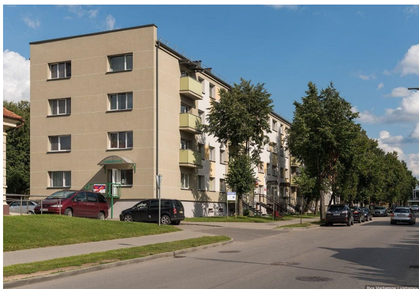
Рисунок 1. Приклад реконструкції радянської будівлі у Латвії [3]
