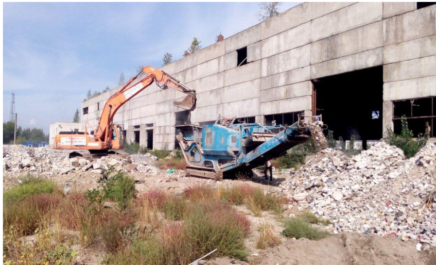
Рис. 1. Переробка демонтованих конструкцій будівлі в щебінь
