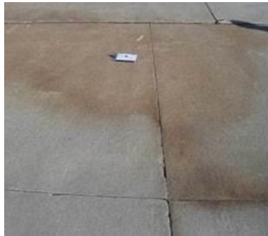
д – витіснення води з-під шару дорожнього покриття;
