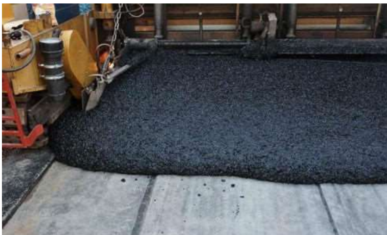
Рис. 2. «Литий» асфальтобетон є сумішшю бітумного в'язучого, кам'яного наповнювача і мінерального порошку, нагрітих та перемішаних в гарячому стані
