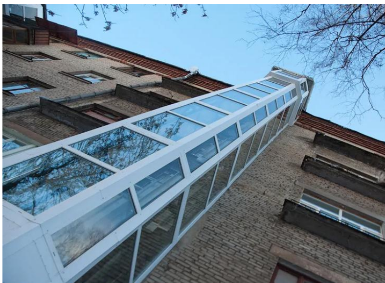
Рис. 1. Використання приставних ліфтів при реконструкції будинків.
