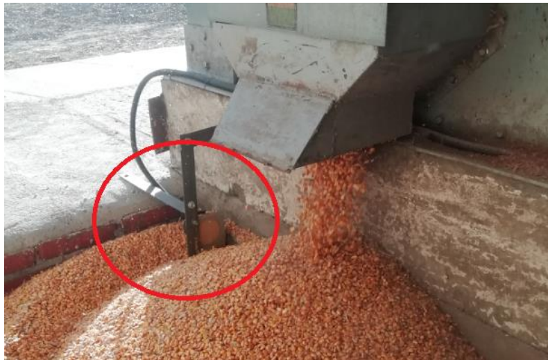
Рис. 2. Змонтований датчик рівня в приймку шнека вивантаження сушарки
