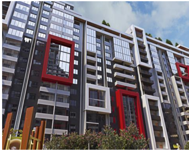
Рис. 1 Загальний вигляд 15-ти поверхового житлового будинка
