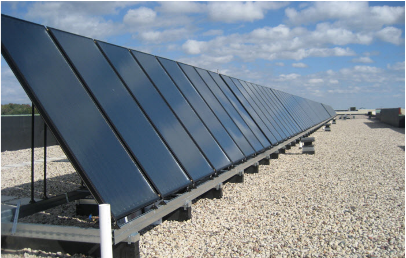
Рис 3. Приклад влаштування звичайних панелей
