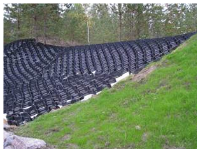
Рисунок 2. Підпірна стінка з армованого ґрунту
