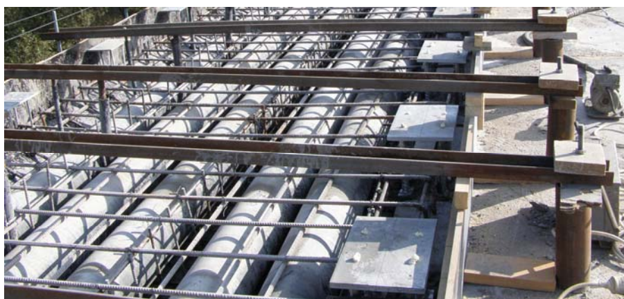
Рис. 4. Сучасні проектні рішення тротуарних конструкцій пролітних будов, що реконструюються у вигляді полігональна накладної тротуарної плити з циліндричними порожнинами: а – принципове конструктивне рішення, б – конструкція тротуару перед бетонуванням. Зображені циліндричні порожниноутворювачі, що утримуються в проектному положенні монтажними пристосуваннями (міст через р. Сіб, м. Гайсин).
