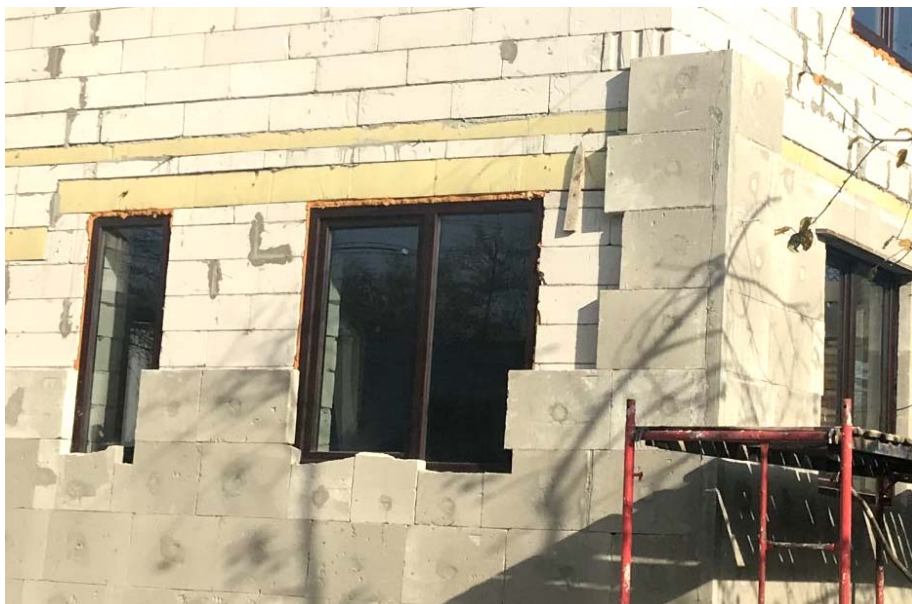
Рис. 1. Принципове рішення шаруватої конструкції зовнішньої стіни з конструкційного газоблоку, утепленої високопористими газоблочними панелями «Веліт» [7].
