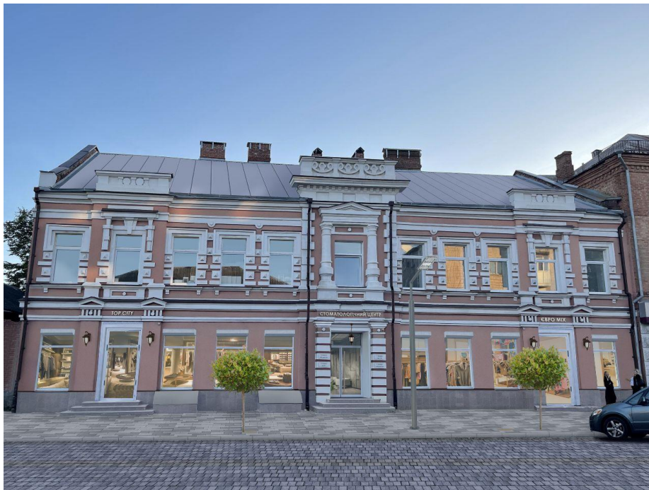
Рис.2. Фасад після очищення від візуального шуму [4]
