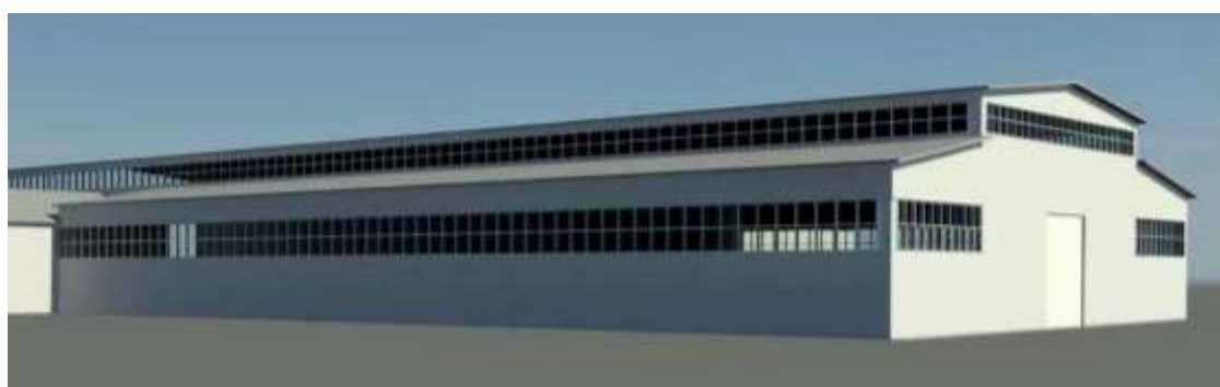
Рис. 1. Виробничо-складська будівля у селищі Рудниця Вінницької області: а – існуюча споруда, збудована за радянських часів, б – архітектурна концепція пропонованої споруди з осесиметричним розширенням улаштуванням двох складських прольотів по обидва боки існуючої споруди з великою площею світлопрозорих конструкцій.
