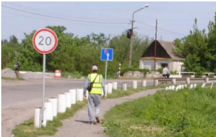
Рис. 1. Аварійна ділянка дороги Р-33 з віражем. Вимушене зниження швидкості руху автотранспорту до 20 км/год. Реверсний рух на мостовій споруді через ненормативну кривизну віражу R < 40 м
