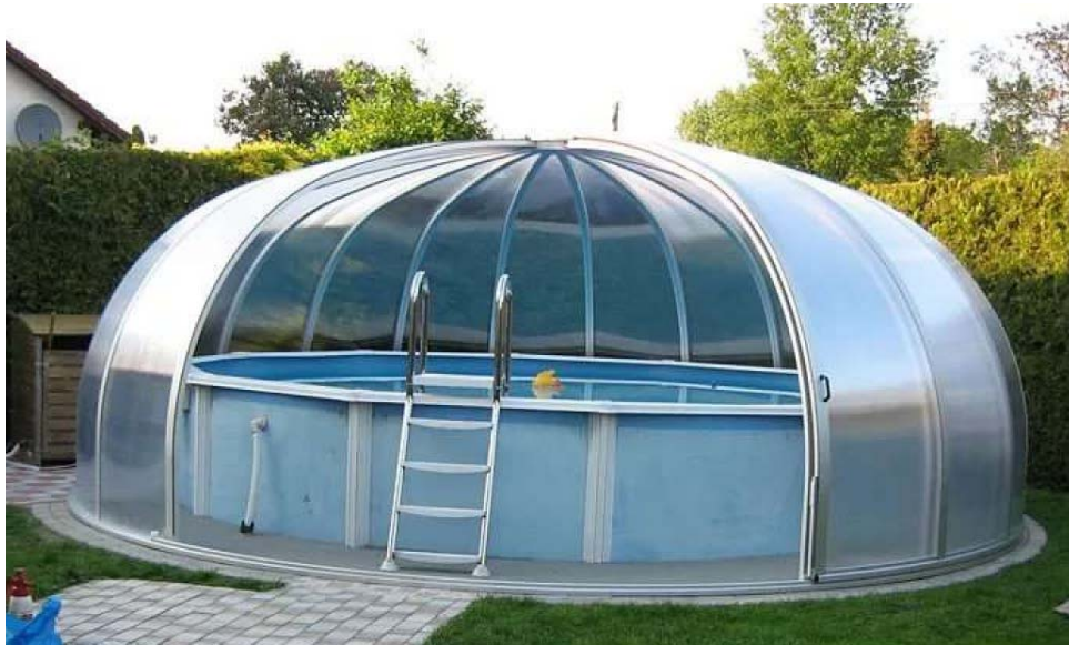
Рис 1. Стандартна еліптична каркасна оболонка над приватним басейном з монолітного полікарбонату [4].
