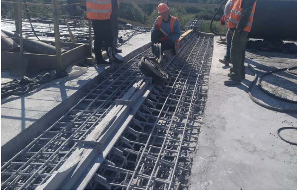
Рис 2. Монтаж металоконструкцій деформаційного шва Maurer.
