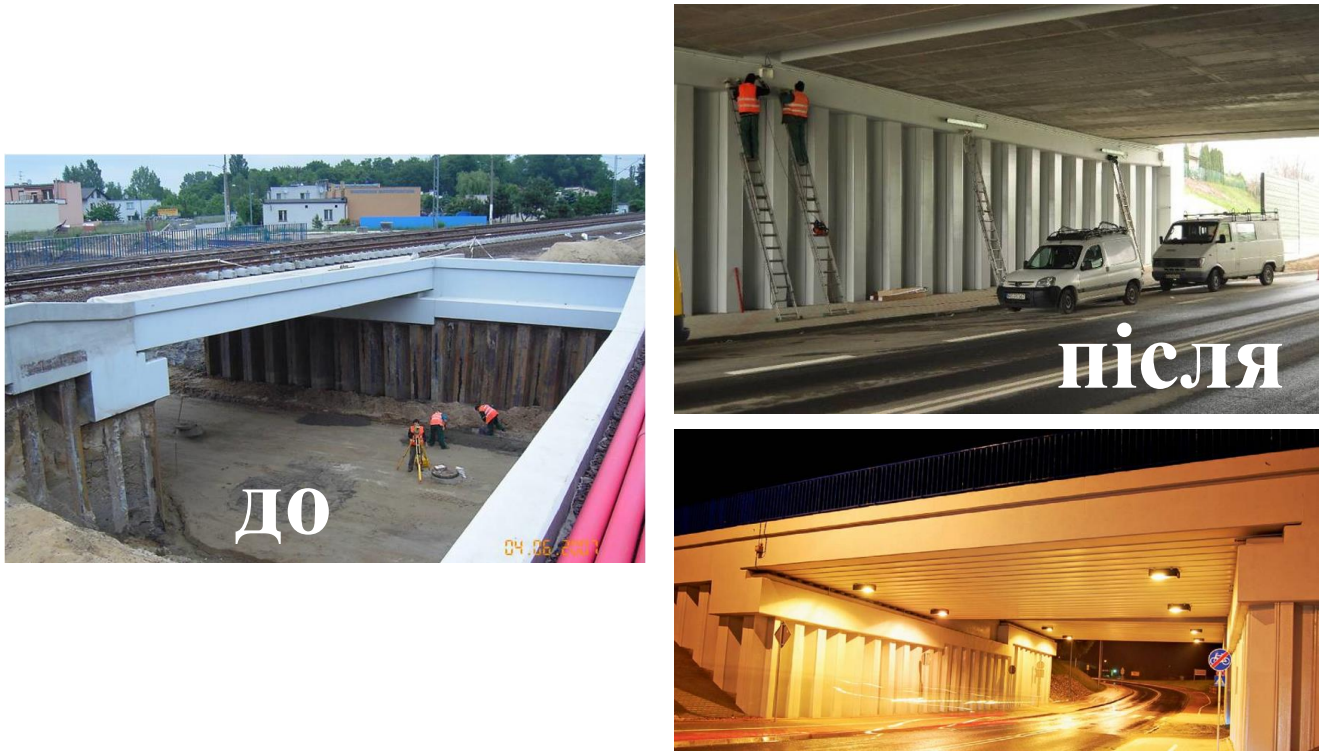
Рис. 1 – Заміна стінок огорожі ЖД виадук, Сважендз, Польща [3].
