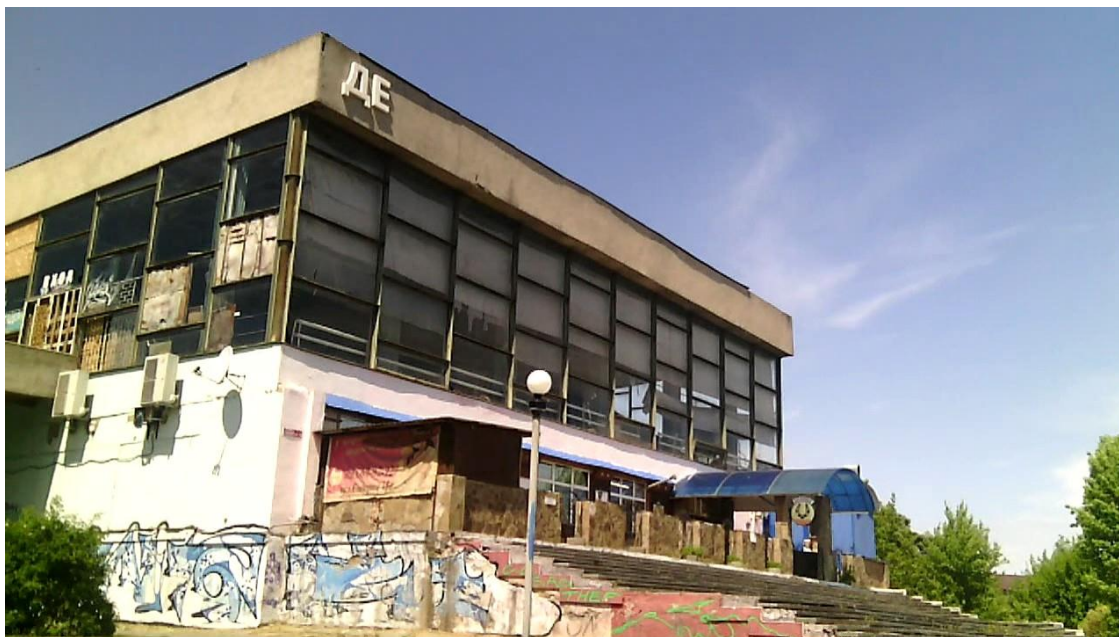
Рис.2 Центральний фасад кінотеатру у 2018 році
