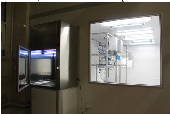
Малюнок 2 - Оглядове зовнішнє вікно і шлюз для передачі матеріалів в чисте приміщення
