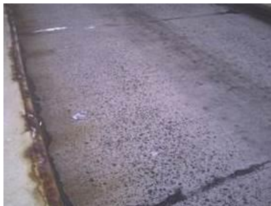
в – полірований заповнювач;
