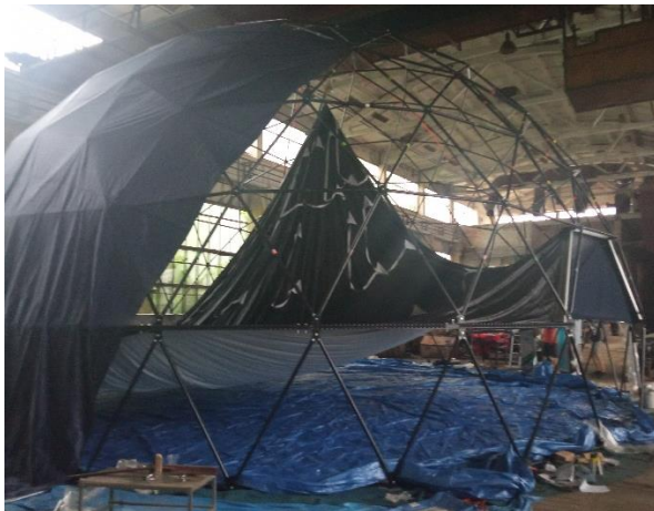
Рис. 1. Геодезичний стрижневий купол Фуллера.
