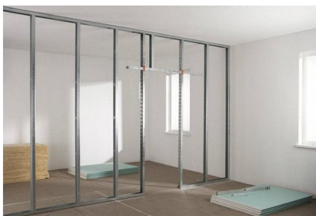
Рисунок 2. Каркас з металевого профілю для міжкімнатних перегородки з гіпсокартону
