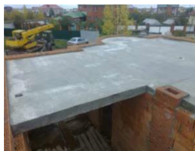
Рис.2 Монолітна плита перекриття
