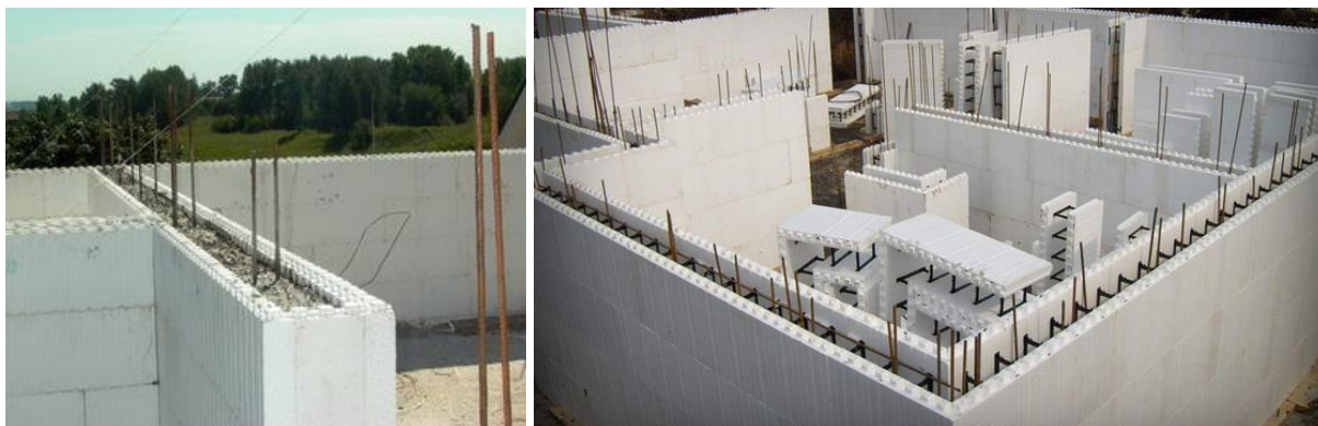
Рис. 1. Будівництво індивідуальних будинків за технологією «Ізодом»
