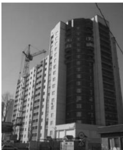
Рисунок 2. Загальний вигляд секції, зведеної на основі, підсиленій шпальним розподільвачем. м. Воронеж вул. Чапаєва 2010 р.
